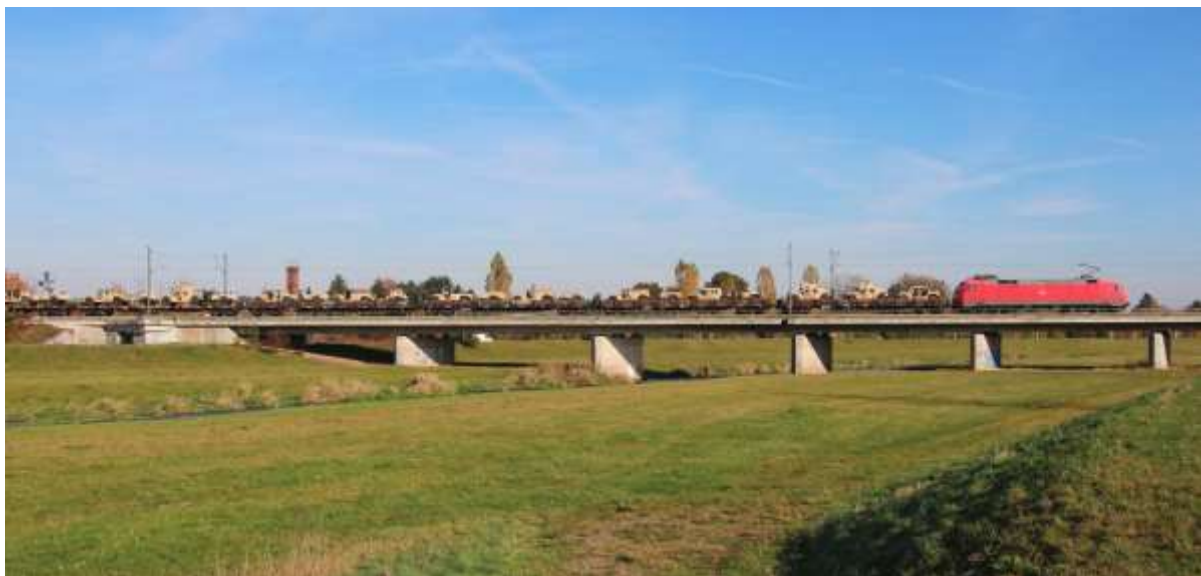
19. Oktober 2017: Ein Militärzug fährt über die Flutrinnenbrücke Glauchau
